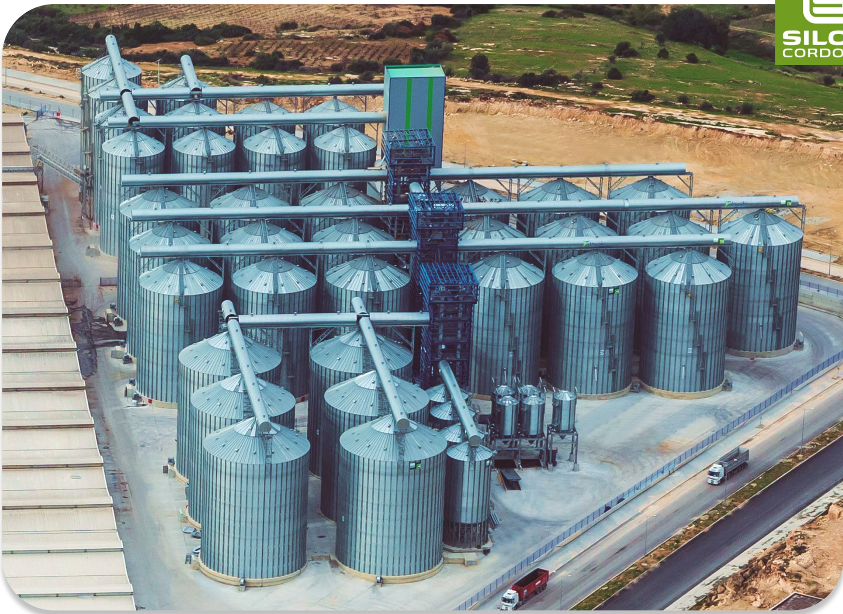
2013 TIRYAKI - TURQUÍA: 19 silos mod. 18,33/22 – 11 silos mod. 14,51/22 – 27 silos carga granel mod. 4,65/6 – 6 silos mod. 21,39/22 – Capacidad total: 200.000 T
