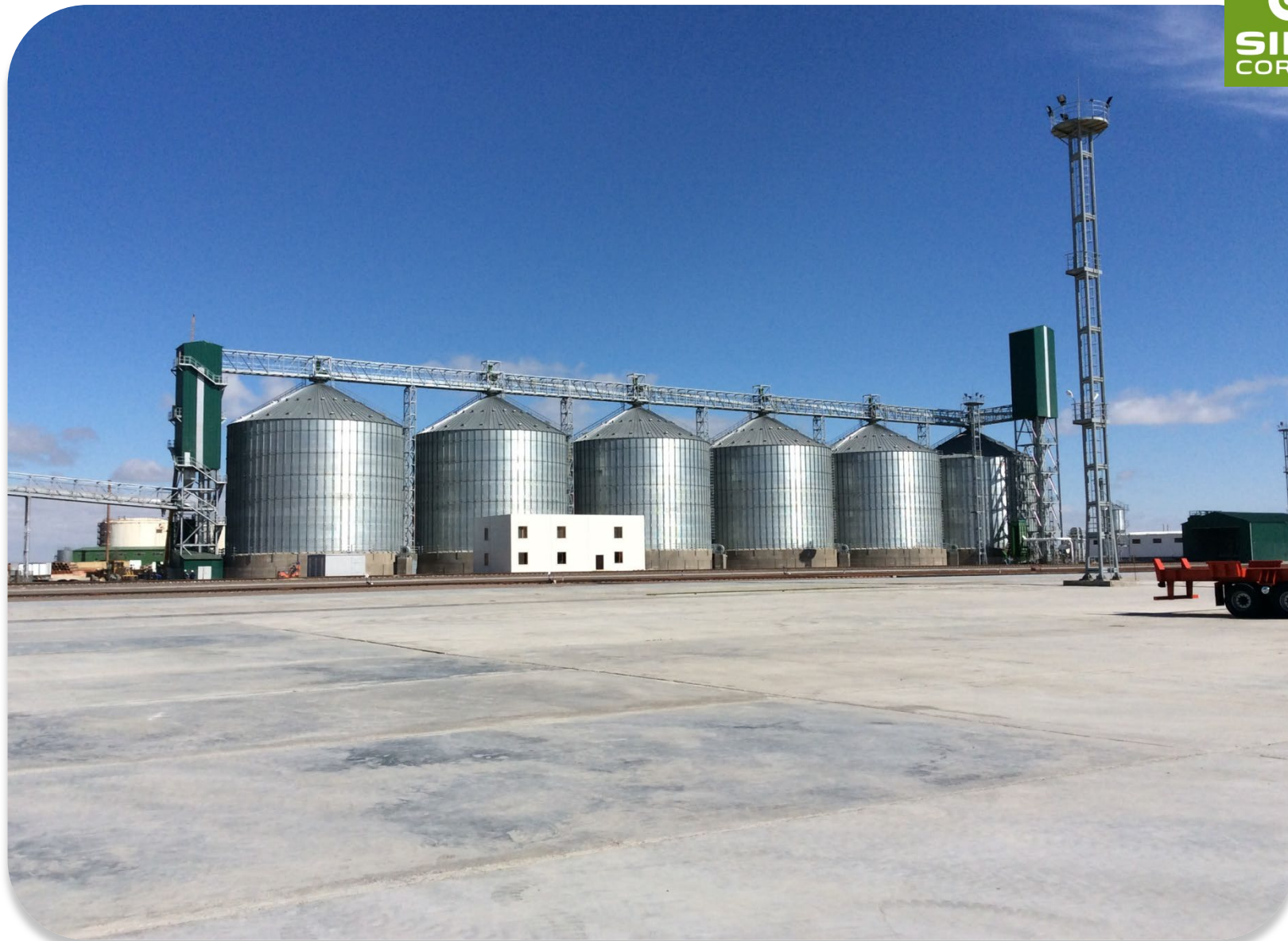
2015 AKT - KAZAJSTÁN: 6 silos mod. 27,50/18 - Capacidad total: 62.000 T
