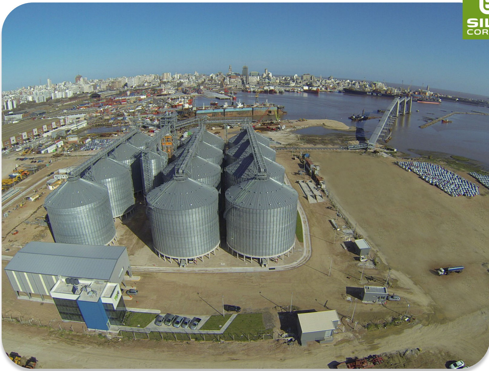
2015 OBRINEL - URUGUAY: 12 silos mod. 27,50/17 - Capacidad total: 121.000 T
