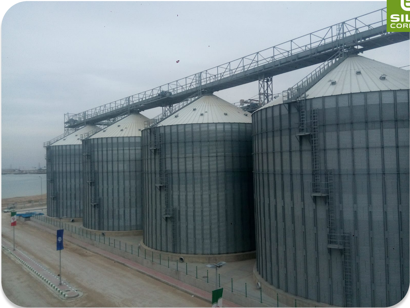
En construcción NKF - IRÁN: 48 silos mod. 24,45/17 - Capacidad total: 367.000 T
