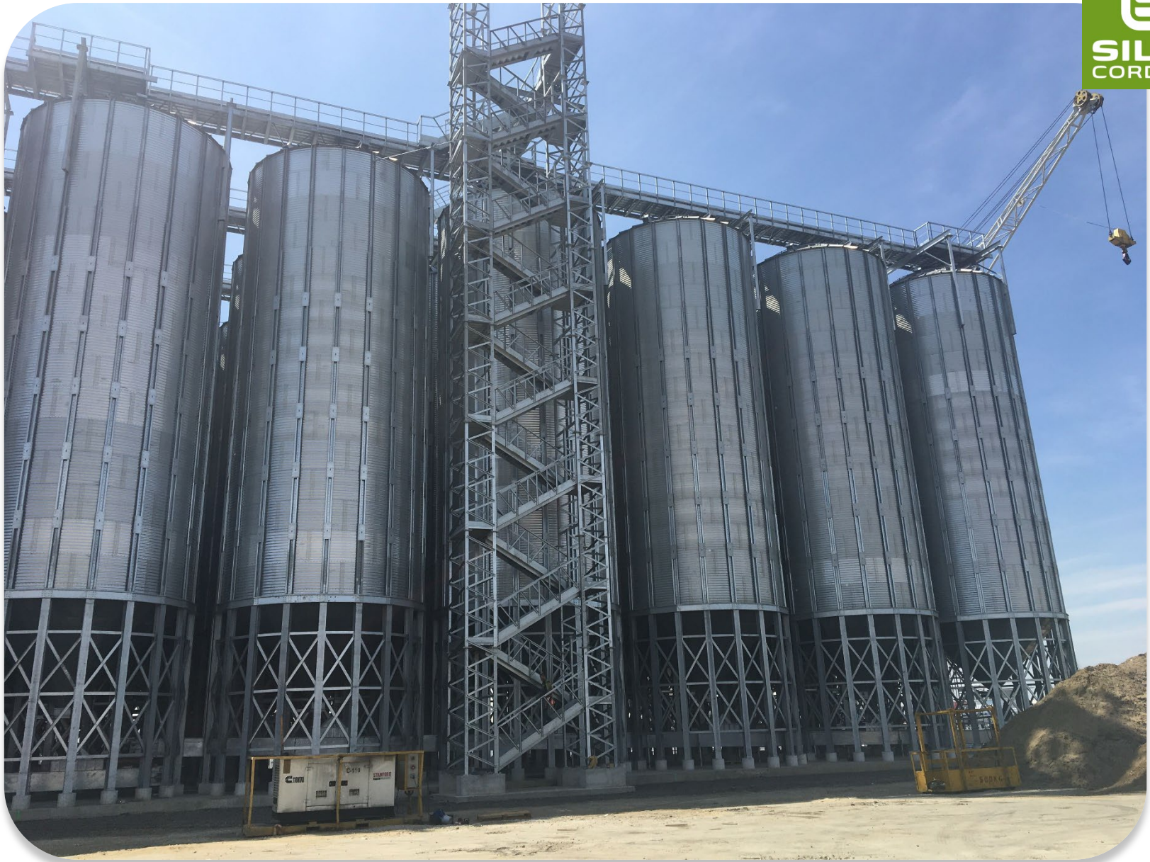
2018 TERMINAL GRANELERA AMBERES - BÉLGICA: 37 silos elevados mod. 07.64/16 45° - Capacidad total: 25.750 T
