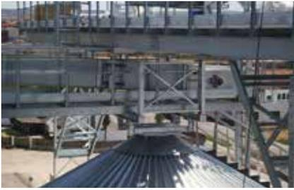
El **soporte de cúpula** sirve de apoyo a la pasarela y se coloca encima de la tapa superior del techo del silo. Hay distintos tipos en función del rendimiento de la maquinaria y del tipo de pasarela.
