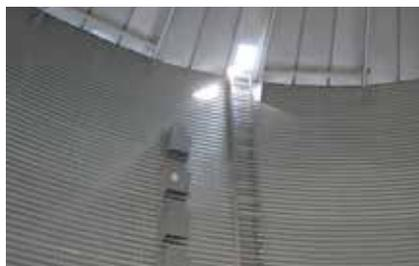
La **escalera interior** del silo facilita el acceso al interior del silo para labores de mantenimiento y el análisis visual del producto ensilado.
