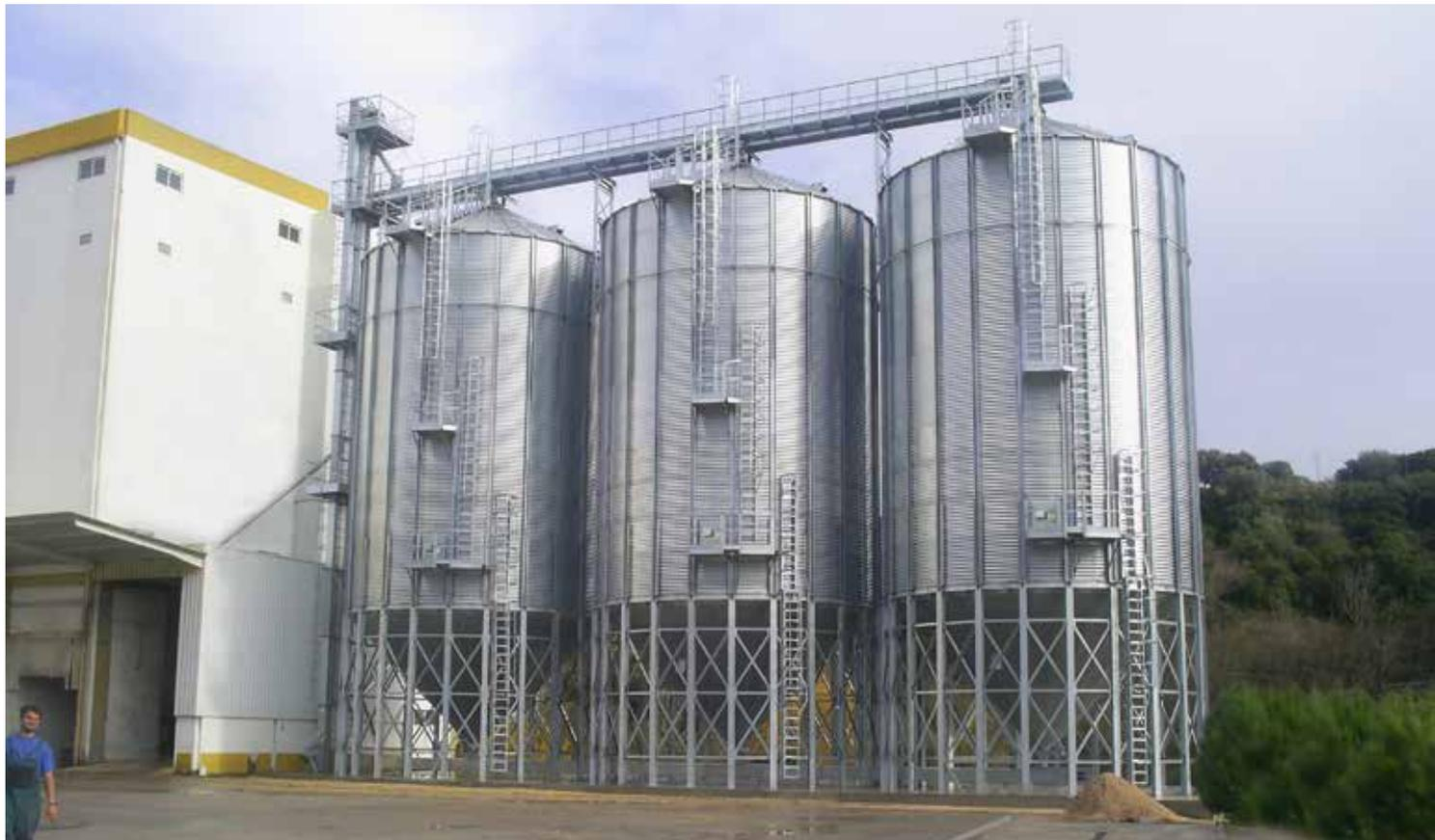
Están concebidos para el almacenamiento de cereales, semillas, leguminosas, pellets y otros productos que requieren condiciones especiales de almacenamiento. El producto almacenado queda aislado del suelo, evitando de esta forma la humedad y aminorando la rotura del grano.
