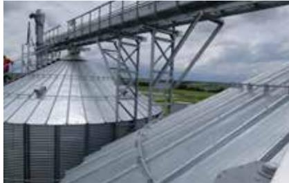
El **soporte lateral** se coloca atornillado a los refuerzos del silo. Se utiliza para maquinaria ligera en silos de hasta 24 m de diámetro. Adicionalmente se puede añadir un soporte oblicuo al soporte lateral dependiendo del modelo del silo y de la pasarela.
