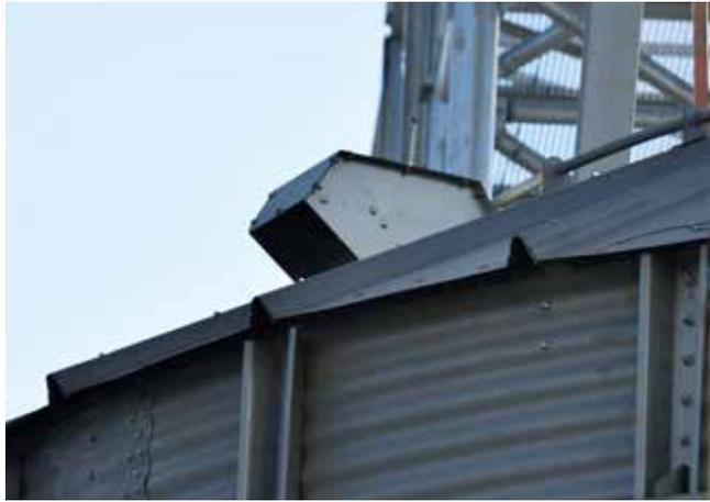
Para instalaciones en zonas climatológicas extremas disponemos de **sistemas de protección de techo** que evitan tanto la entrada de nieve en el silo a través de las chimeneas, como su acumulación en zonas susceptibles a ello. Todos nuestros silos van incorporados con protecciones para evitar la entrada de pájaros al interior del silo.
