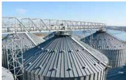
La **plataforma en la cúpula** es un elemento opcional y favorece las tareas de supervisión de las conexiones entre la maquinaria y el silo.
