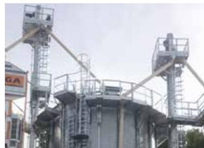
La **barandilla perimetral** es una estructura de mejora de seguridad para labores de mantenimiento en el techo del silo.
