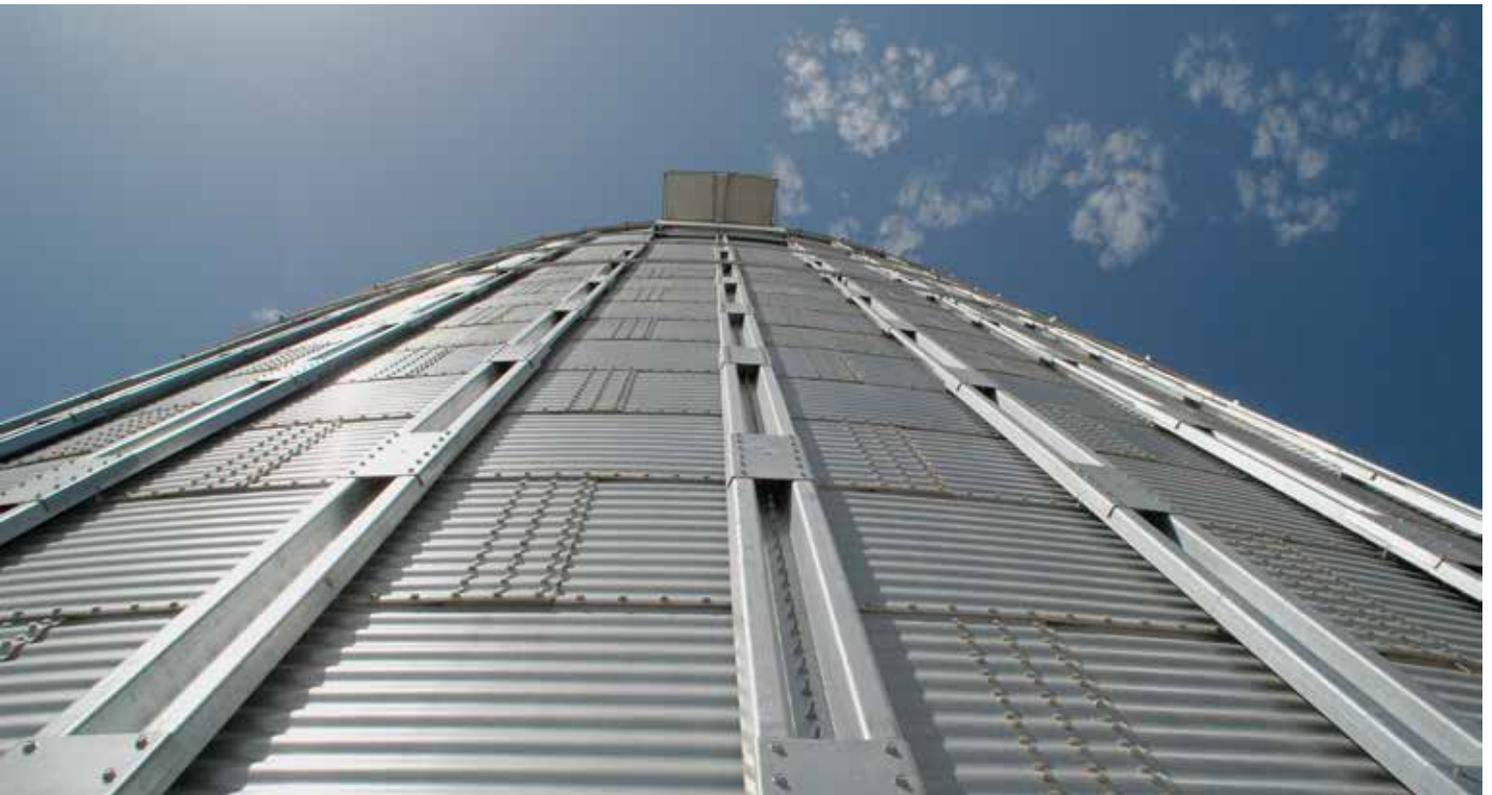
Usamos **acero de límite elástico** desde 450 MPa para virolas y para refuerzos. Silos Córdoba es la primera empresa fabricante de silos que estableció como estándar de su fabricación el acero galvanizado Z-600. Este recubrimiento supone un contenido de zinc de 600 gr/m<sup>2</sup> y equivale a un espesor por cara de 42 micras, lo que le confiere la mayor durabilidad incluso en los ambientes más agresivos (establecidos en la Norma ISO 9223).
