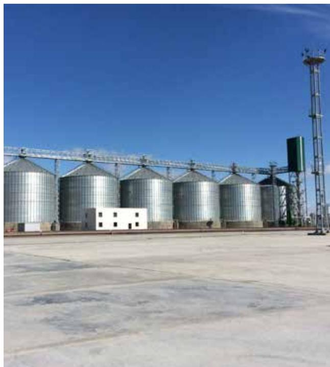
Nos silos à corps cylindrique et à plafond incliné à 30 ° sont destinés au stockage du grain, des semences et d'autres produits. L'équipe d'ingénierie de Silos Córdoba conçoit ses silos en suivant un ensemble de normes pour s'adapter aux besoins de ses clients, dont les normes européennes EUROCODE et la norme américaine ANSI.
