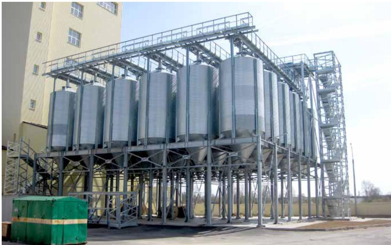
Nous concevons et nous fabriquons des boisseaux de chargement dotés d'une structure de soutien pour le passage de camion ou de train. Cette structure est constituée de profils de nœuds rigides laminés en T double et fabriqués en acier S275JR galvanisé à chaud. La hauteur standard de l'orifice de sortie entre le boisseau et le sol est de 4500 mm et nous sommes en mesure de nous adapter aux besoins du client.
