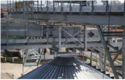
**Le support central sert de soutien à la passerelle** et doit être mis au-dessus du couvercle supérieur du toit du silo. Nous avons plusieurs types disponibles en fonction du débit des machines et du type de passerelle.
