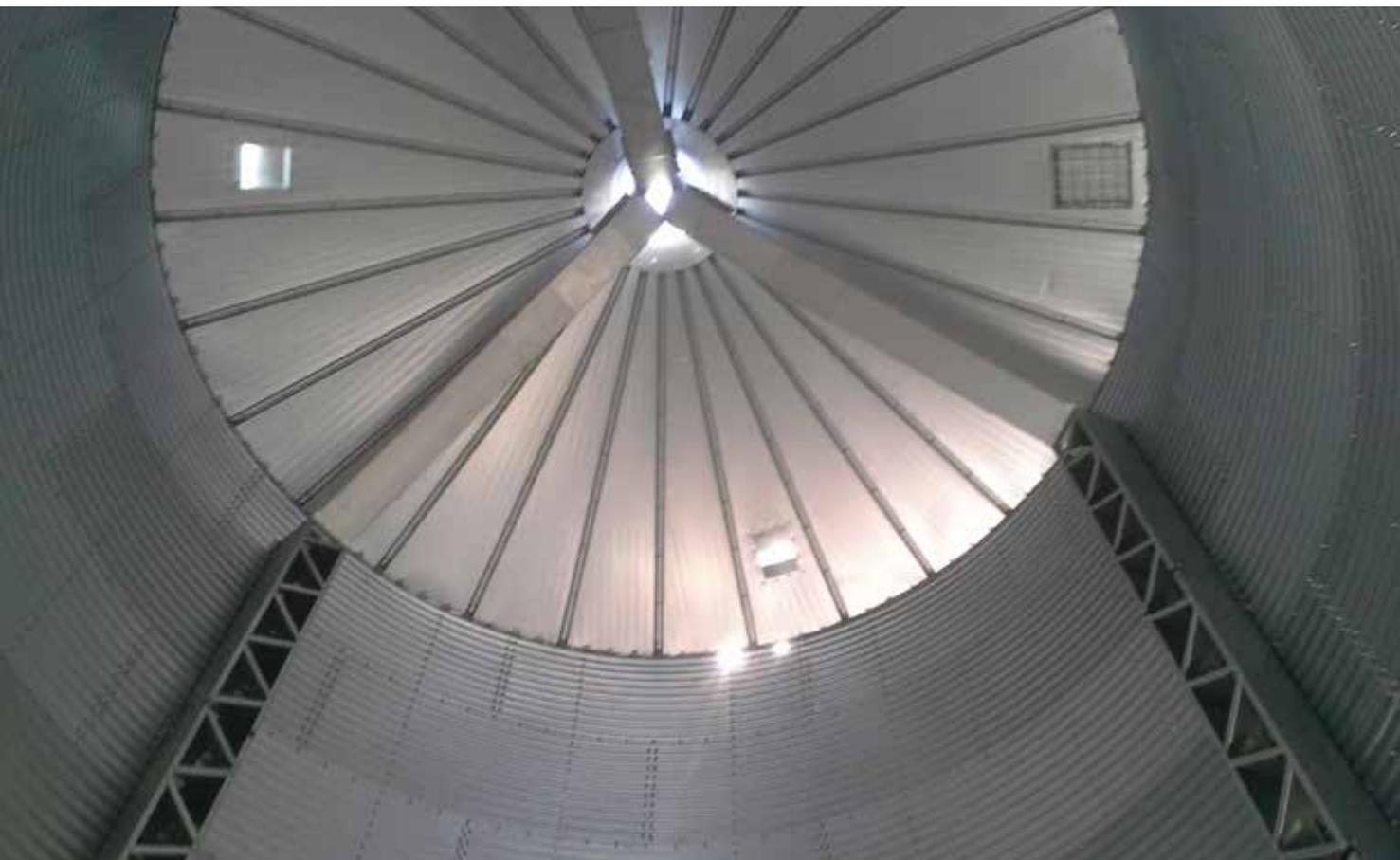
**Le toboggan** est un conduit intérieur situé sur le mur du silo, pour que lors du chargement (du silo), le produit puisse glisser homogénément, évitant ainsi de le briser.
