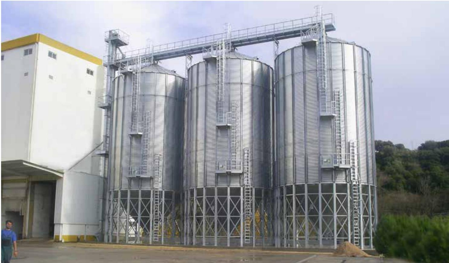
Ils ont été conçus pour le stockage de céréales, de semences, de légumineuses, de pellets et d'autres produits exigeant des conditions de stockage spéciales. Le produit stocké reste isolé du sol pour empêcher l'entrée d'humidité et pour éviter de briser le grain.
