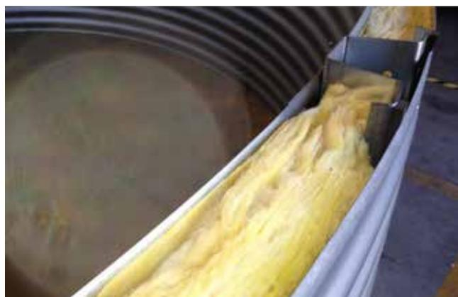
Tôle double plus matériau d'isolation : Le matériel d'isolation est ajouté entre les tôles. Les matériaux les plus habituels sont la mousse de polyuréthane et la laine de verre.
