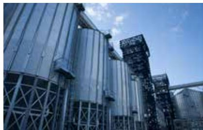
Avec ce type de silo, le coût de réalisation est réduit du fait qu'on n'aura pas besoin de la vis-balayeuse, les travaux de fondations sont simplifiés, ce qui permet aussi de réduire les coûts du génie civil et d'accélérer
